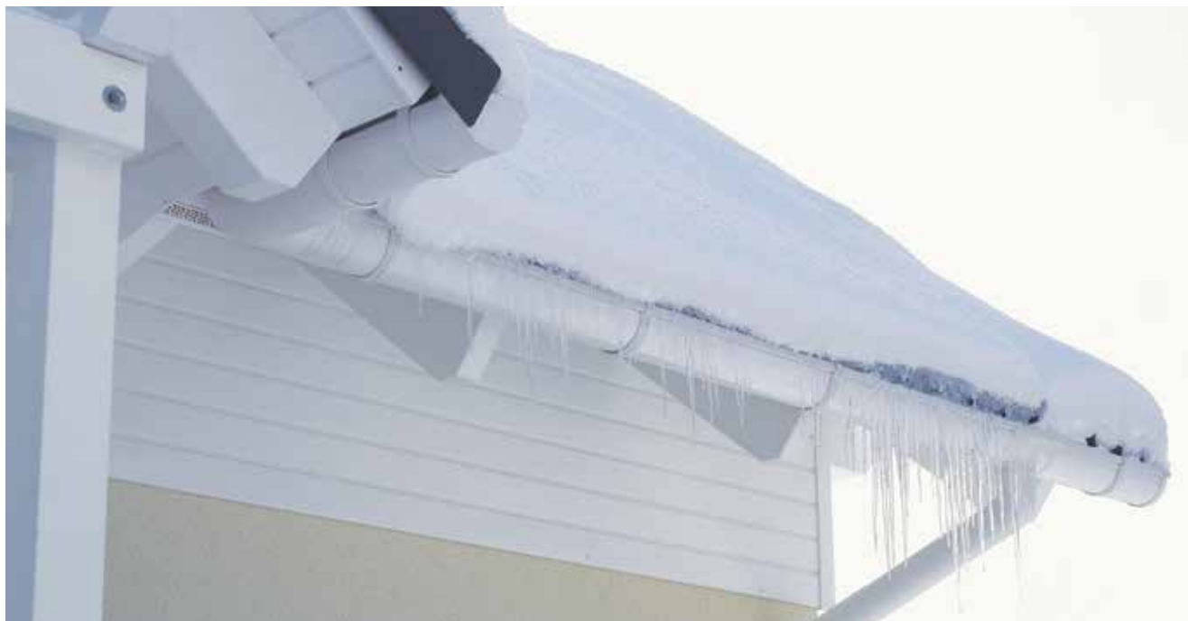
Istapper og issvuller er tegn på dårlig isolasjon og kan gi fuktproblemer i takkonstruksjonen
