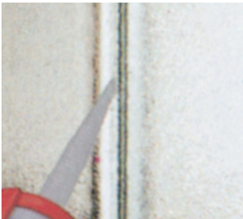
Fuging av 2 lags glass
