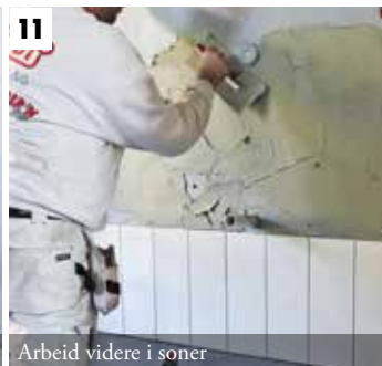
Mål til og tilpass flisen underveis
