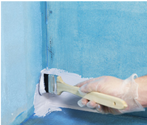
Installering av Mapei IC/EC hjørne mansjett ved hjelp av Mapegum WPS
