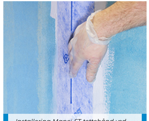
Installering Mapei ST tettebånd ved hjelp av Mapegum WPS, overgang vegg
