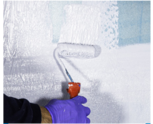
Påføring av Mapegum WPS membran med eksempelvis rulle
