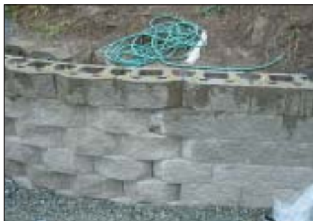
Ulike typer blokker på rett mur og i kurver
