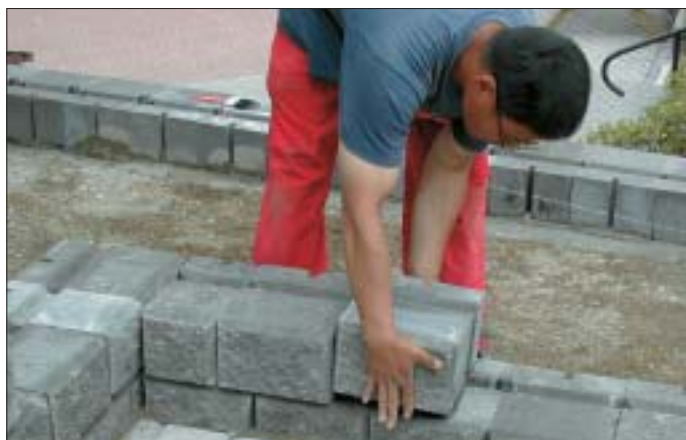
Manuell legging av betongblokker
