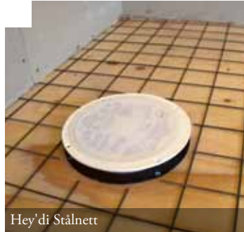
3 Kramp fast stålnettet til underlaget
