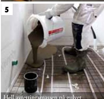
5 Hell avrettingsmassen på gulvet
