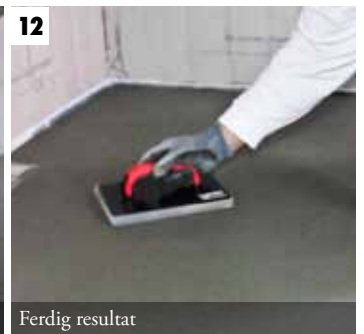
8 Komprimer støpemassen
