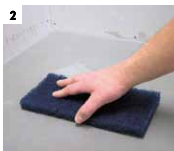
2 Slip underlaget lett mekanisk
