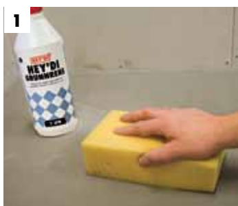
1 Rengjør overflaten
