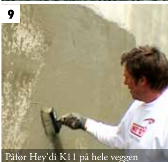
9 Påfør Hey'di K11 på hele veggen
