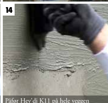
14 Påfør Hey'di K11 på hele veggen
