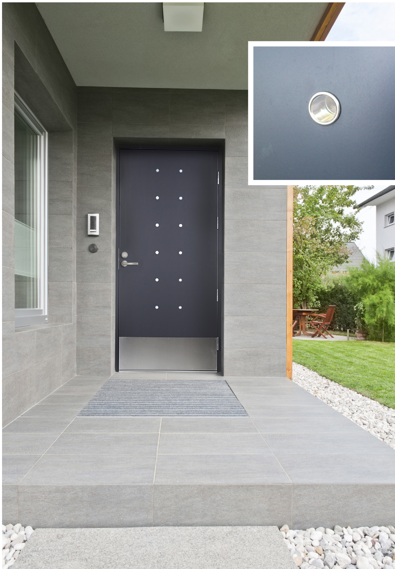
Inngangsparti med Fjell 02 i grå NCS S 6500-N. Fjell 02 har 12 akrylstavar, som slepp lys gjennom dørbladet.
