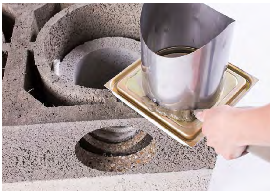
Påføre Pipekleber P38 innvendig på sotluken.
