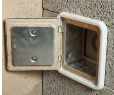
Pass på at den innvendige rammen på sotluken skyves inn mot rammene på sotlurerøret. Deretter monteres medfølgende dørstein. Påfør fugekitt mellom rammene for optimal tetthet.
