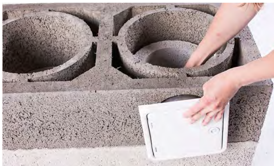
Sotluken monteres og eventuell overskytende pipekleber fjernes.
