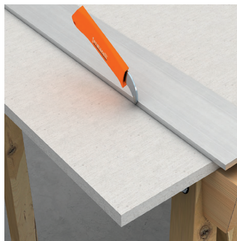
2. Rissing med Fermacell rissekniv
