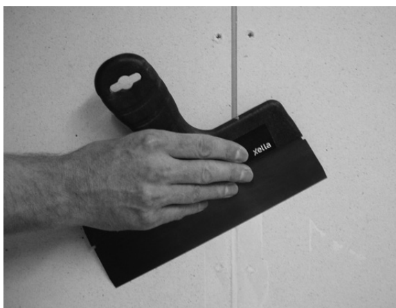
3. Fyll fugen helt med Fermacell Skjøtesparkel.
