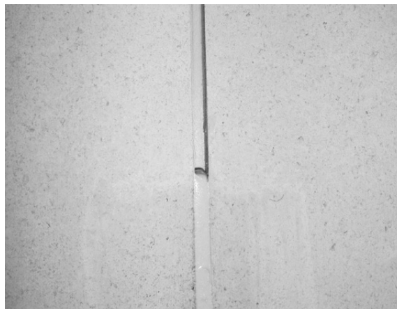
2. Fugebredde på 5-7mm (0.5 x platetykkelsen)
