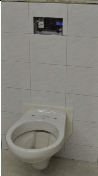
9b. Monter klosettet og skru det inn mot vegg.
