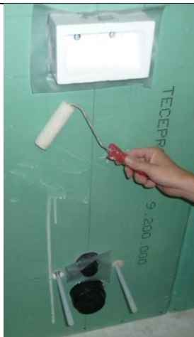
3. Påfør primer på frontplaten
