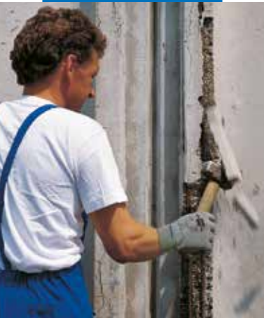
Fjerning av nedbrutt betong
