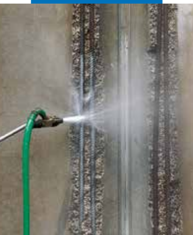
Rengjøring av armeringsstenger
