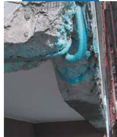
Armeringsstenger på frontside av en balkong behandlet med Mapefer 1K
