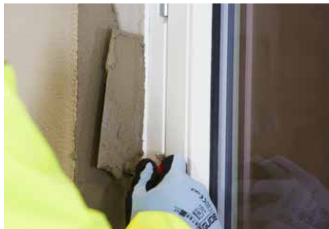
Innpussing av Mapetherm Corner Profile .
