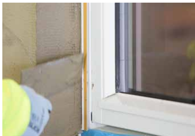
Innpussing av Mapetherm Profil W .
