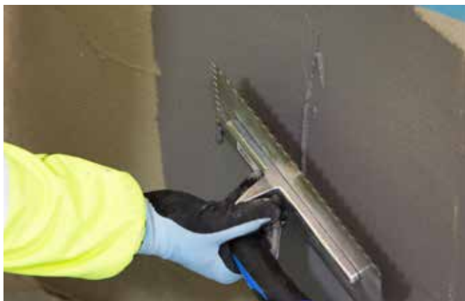
Påføring av Mapelastic .
