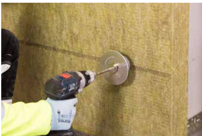
Benytt Mapetherm Tool for fiksering av plugg.
