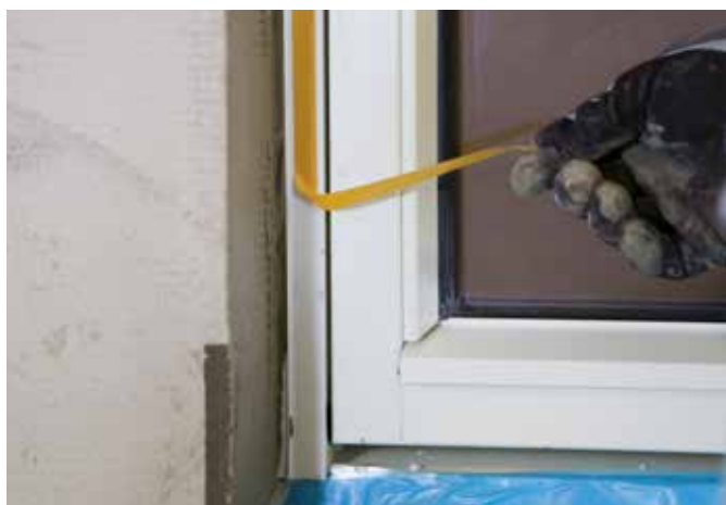
Den midlertidige fliken på Mapetherm Profil W benyttes til å feste tildekningsplast over vinduet.
