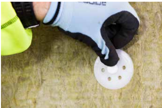
Benytt Mapetherm Tool for fiksering av plugg.
