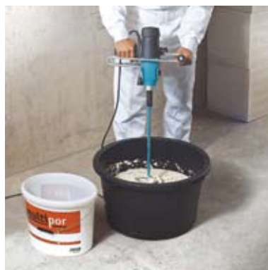
Ytong Multipor Leichtmörtel oprøres med vand. 20 kg pulver blandet med 8 l vand giver ca. 30 l mørtel.
