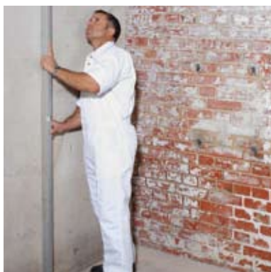
Underlaget rettes af til +/- 3 cm målt over en retholt på 2 meter. Større huller og lunger spartles eller puds.
