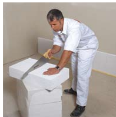
Ytong Multipor tilpasses nemt og præcist med en fintandet sav og slibenet.
