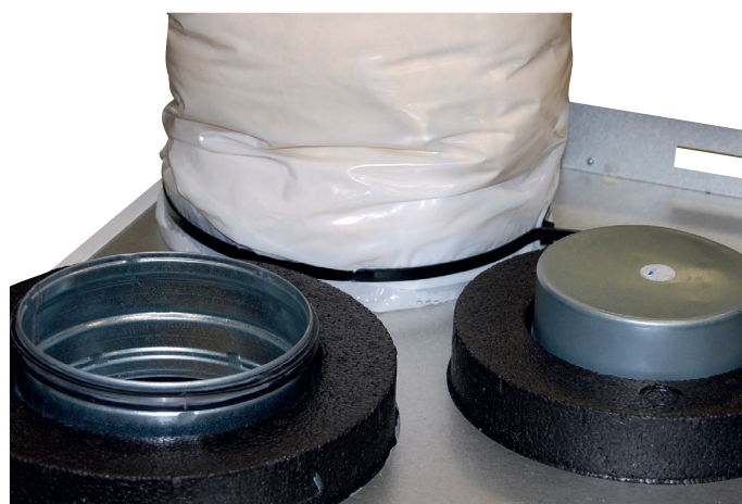
Ferdig montert kanal.
