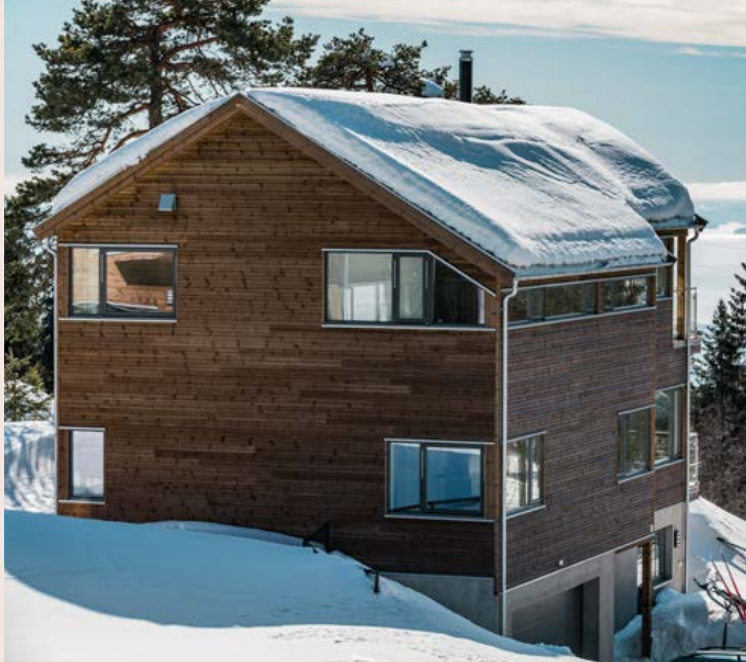
Høyt oppe i Voksenkollen har 13 eneboliger blitt kledd med MALM 100 med jernvitrol.
