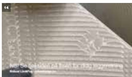
15 Flisen skal plasseres rett mot i flislimet for å sikre en god limdekning. Forbruk skal på flisoverflaten.
