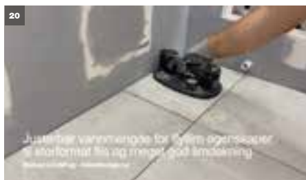
17 Sikr at råk og full limdekning ut på underlaget og baksiden av flisen.
