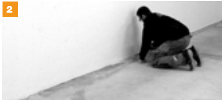
2 Masker alle områder som ikke skal påføres epoxy
