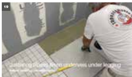
16 Sikr at råk og full limdekning ut på underlaget og baksiden av flisen.
