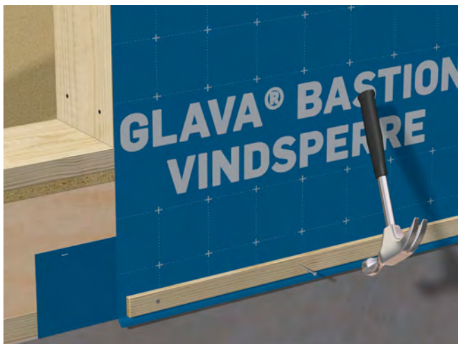
Fig. 36 Klemming av vindsperre mot grunnmursvill
