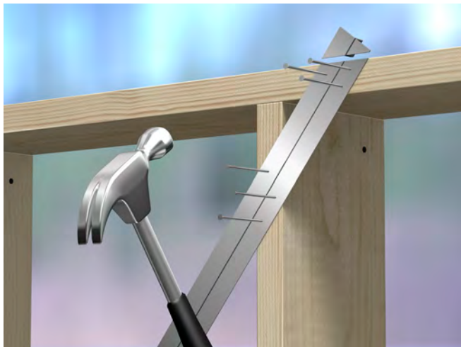
Fig. 32 Spikring av avstivningsstag
