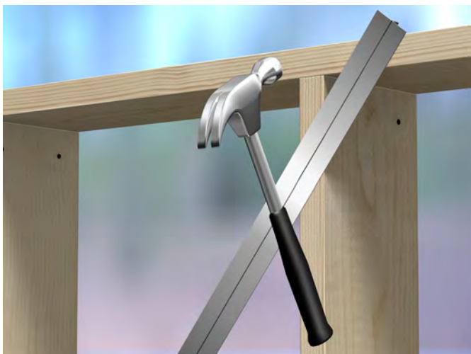
Fig. 31 Avstivningsstag bankes inn i slissen
