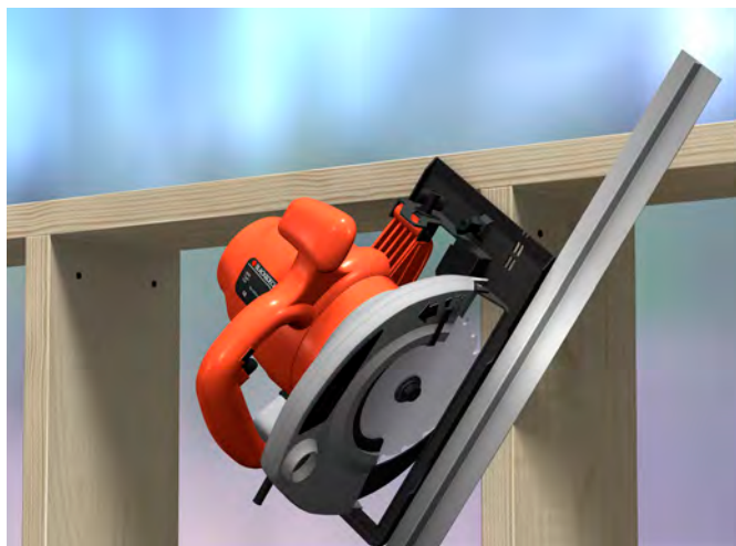
Fig. 30 Slissing i stenderverk for avstivningsstag
