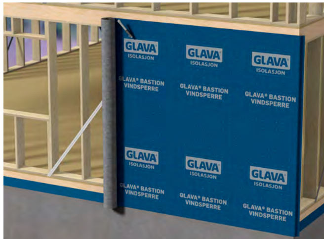
Fig. 34 Montering av etasjehøy vindsperre
