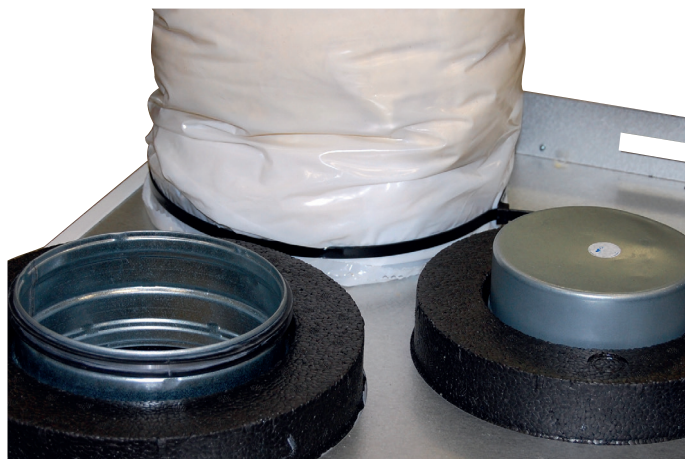
Figur 21 Ferdig montert kanal
