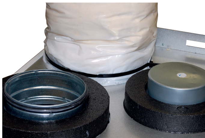
Figur 21 Ferdig montert kanal
