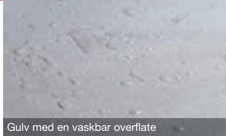
Gulv med en vaskbar overflate
