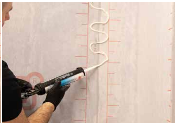
Påfør Hey'di Protac 25 jevnt fordelt ca. 50 mm på hver side av skjøten.
