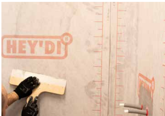
Monter folien kant i kant med den allerede monterte folieduken. Luftbobler eller annet må rettes ut.
