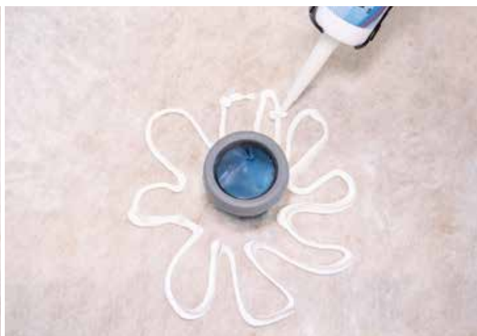
Påfør Hey'di Protac 25 rundt rørgjennomføringen.
