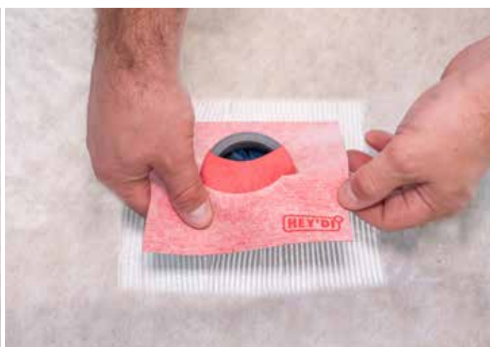
Monter tilpasset Hey'di RM rørmansjett
