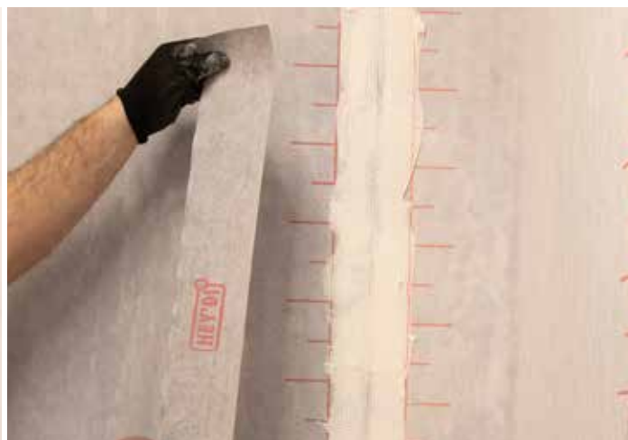
Klipp til Hey'di Tettebånd i riktig lengde. Monter og trykk Hey'di Tettebånd på plass i det våte limet Hey'di Protac 25.
