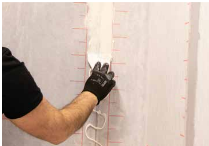
Stryke ut limet, Hey'di Protac 25, med egnet limspreder og fordel jevnt mellom de røde linjene på foliedukene.
