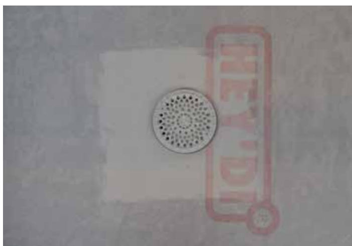
Trykk ned klemringen med hendene eller foten og også den medfølgende slukristen.
