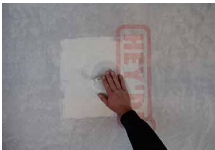
Dagen etter skjærer man nøye gjennom folien og slukmansjetten med en sirkulær bevegelse rundt sluket
