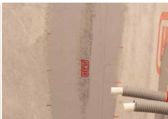
Slik skal en montering med Hey'di Tettebånd se ut.
