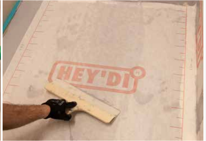
En kappet lengde av folieduken monteres i den våte Hey'di K20.
