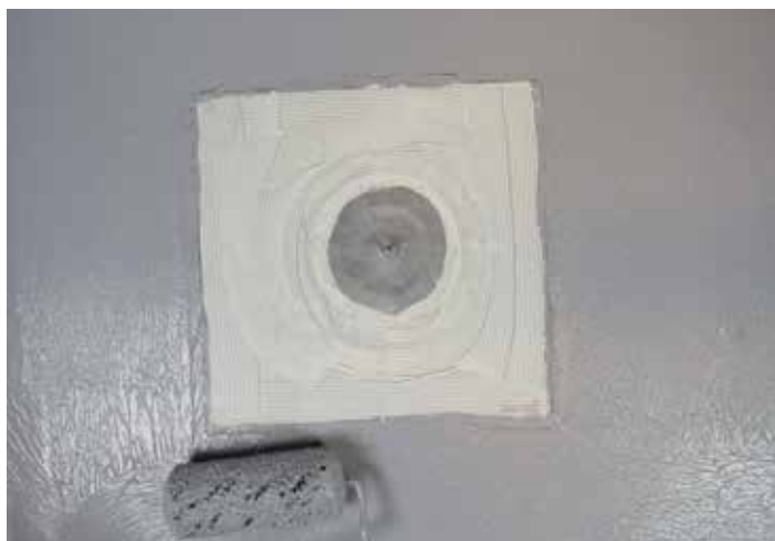
Rull ut Hey'di K20 for en folielengde, IKKE på slukmansjetten.
