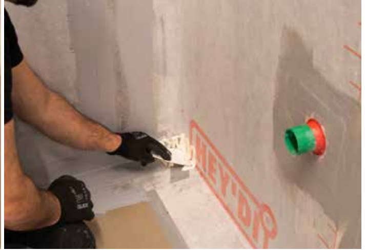
Bruke egnet limspreder for å jevnt fordele limet.
