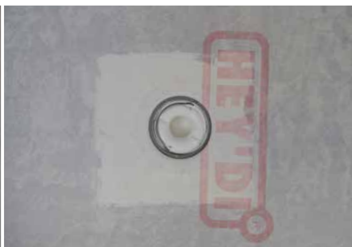
Slik skal det se ut når klemringen er riktig montert. Viktig å kontrollere at klemringen ikke er skjev og sitter ordentlig fast.
