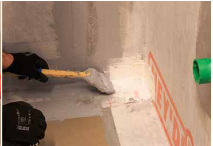
Unngå luftbobler og pensle alle kantene på hjørnemansjetten med Hey'di K20.
