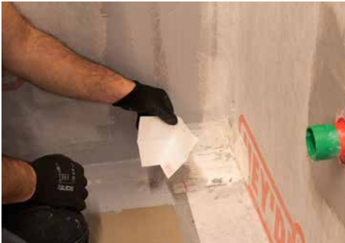
Pass på at det er nok lim som dekker Hey'di IH90 mansjetten, er det ikke det må du påføre mer lim, Hey'di Protac 25.
