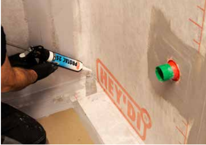
For alle tettedetaljer kreves det montering med Hey'di Protac 25. Her skal det monteres Hey'di IH90 (Innvendig hjørne)
