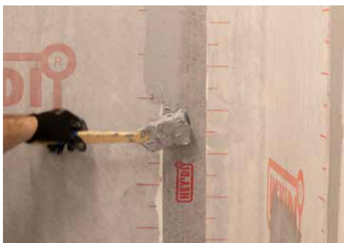
Lukk overlappsskjøtene på begge sider med Hey'di K20, ca. 30 mm så ikke vann eller damp har mulighet til å trenge inn.
