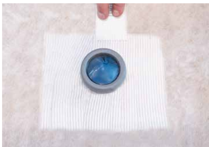
Spre ut Hey'di Protac 25 med egnet limspreder.
